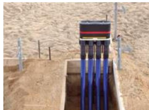
In der DIN 18322 ist vorgeschrieben, dass beim Verlegen von Kabeln und Schutzrohren für einen gas- und wasserdichten Einbau zu sorgen ist.
