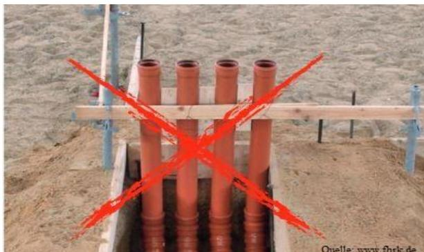
Hauseinführungen mit herkömmlichen KG-Rohren sind nach DIN 18322 und DVGW VP 601 nicht zugelassen. Siehe hierzu: [www.fhrk.de](http://www.fhrk.de)
